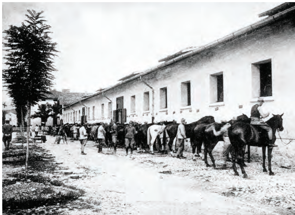
FIG. 10 Le stalle all'indomani della presa di possesso da parte di reparti del Regio Esercito italiano (coll. Ezio Cociancig).
