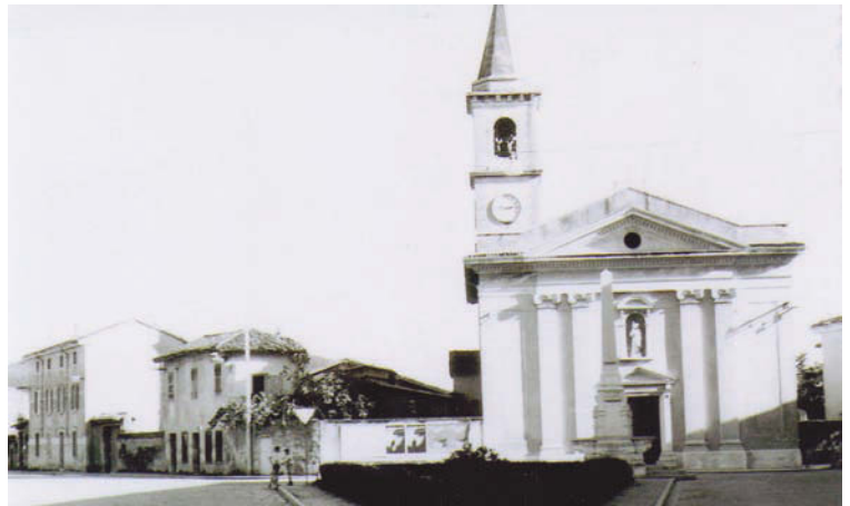
Casa Pecorari e la "Baracca" poche settimane prima della demolizione nel 1962.
