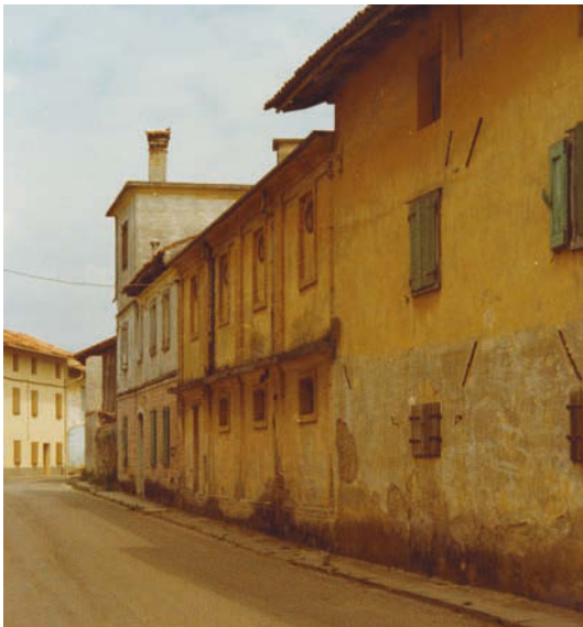
Casa Wolf a Farra d'Isonzo negli anni Ottanta al tempo della sua demolizione.
