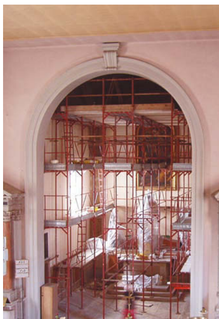
La chiesa di San Rocco durante i lavori eseguiti tra la primavera e l'estate del 2006.
