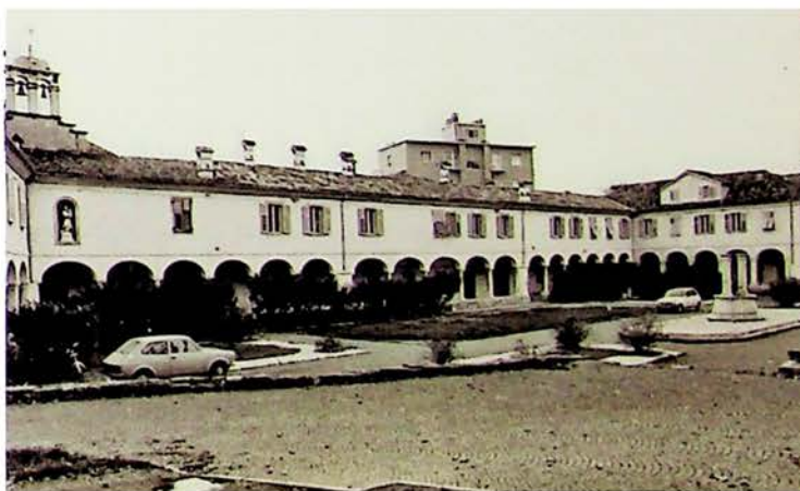
Il chiostro nel 1980 circa, dopo i lavori.
