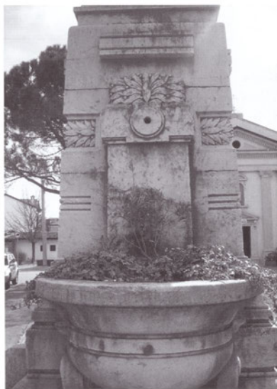
Particolare della fontana, la vasca dell'acqua oggi è una fioriera
