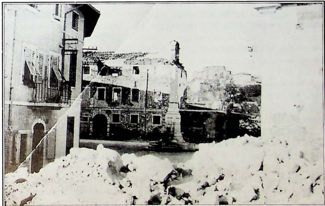
Ancora un'immagine di Piazza San Rocco in tempo di guerra. In primo piano sono ben visibili le rovine della casa canonica e sullo sfondo le macerie della scuola, demolita negli anni successivi.
