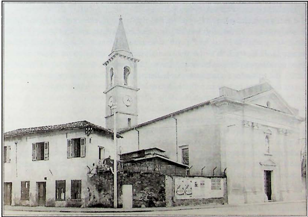
Una delle ultime foto della excasa Pecorari, prima dell'avvio dei lavori di demolizione intrapresi alla fine del gennaio 1962: la "zata del leon" era murata nella parete esterna. Tra la casetta e la chiesa si nota la baracca adibita ad oratorio nel secondo dopoguerra.
