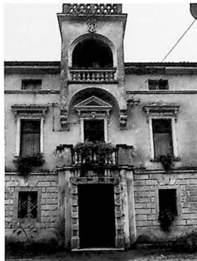
Particolare facciata anteriore.
