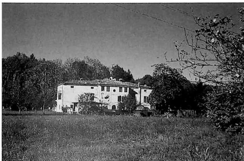
Facciata posteriore della villa.
