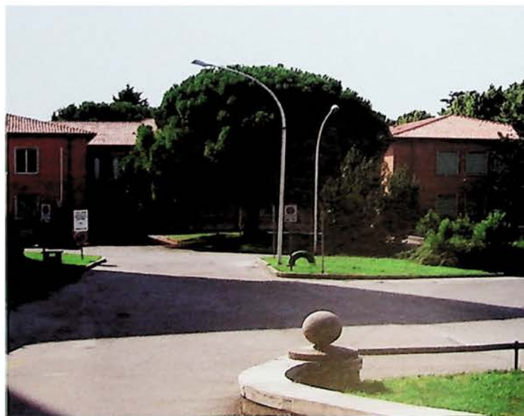
Fig. 7 Edificio ex Ospedale Civile, 2009, parte interna del complesso ospedaliero (foto L. Debeni).
