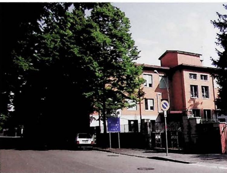
Fig. 6 Edificio ex Ospedale Civile, 2009 (foto L. Debeni).
