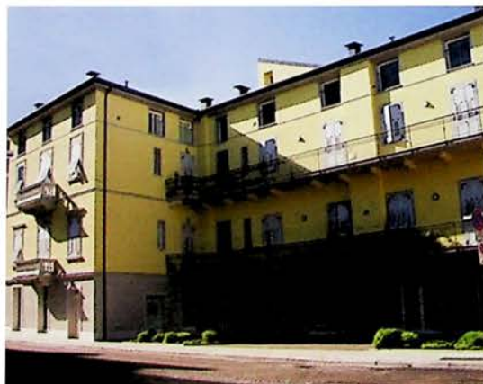
Via N. Sauro n.ri 10- 6, casa Neuhaus oggi. Dopo i recenti lavori di ristrutturazione e innalzamento dell'edificio, il corpo base e il primo piano sono rimasti immutati rispetto l'originale costruzione seicentesca. foto M. Sisti
