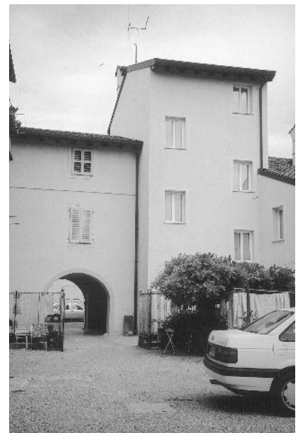
Fig. 8 - Retro dell'edificio in via Parcar 6. (Foto Debeni, 2003)
