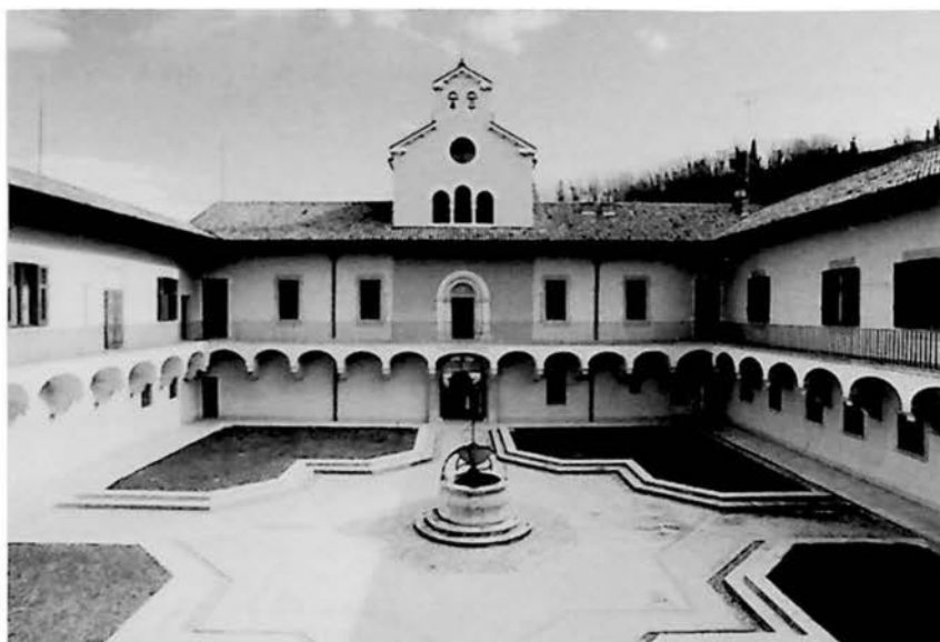
Il cortil interno dopo dai lavôrs di ristauro.
