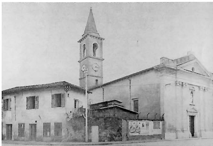
Fig. 11 - Casa Pecorari di via Lunga 2, ora demolita. (Collezione Guido Bisiani)
