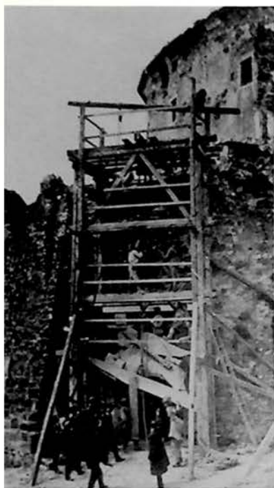
25 aprile 1919: operazione di sollevamento del Leone di San Marco mediante paranchi fissati su una impalcatura eretta in corrispondenza all'ingresso principale del Castello. Quest'ultimo porta ancora i segni distruttori della guerra 1915-1918.
