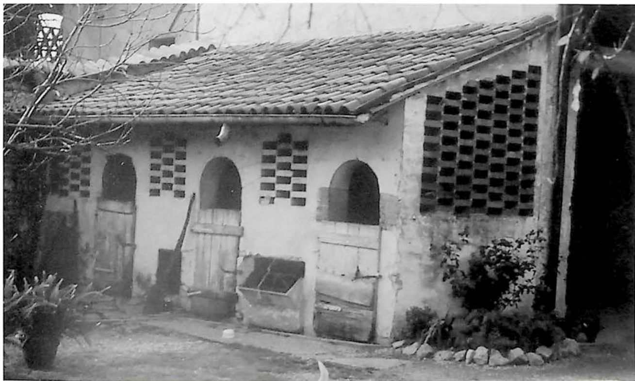
Tipico porcile (ciot, kliu) in muratura con porta bassa e truongolo aperto verso l'esterno. Fratta di Romans.
