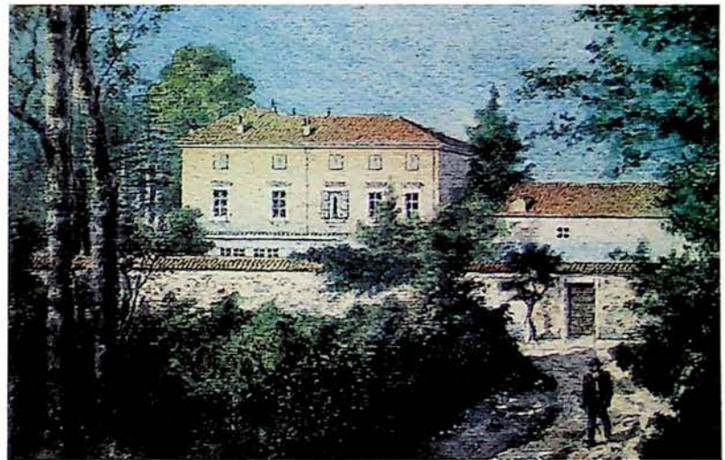
Immagine di inizio secolo della Villa Tusculum in San Pietro (distretto di Toscolano). Vista dal lato Ovest. (Fototeca dell'Archivio Storico Prov. di Gorizia).
