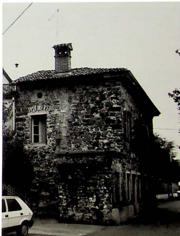
La casa di Pietro Lasciak all'inizio dell'attuale via Parcar.
