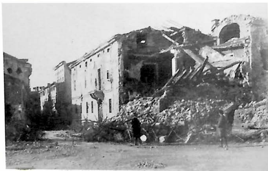
Palazzo semidistrutto dei baroni Ritter ubicato all'angolo delle odierne vie Balilla e Orzoni, in un sito che fu di proprietà della nobile famiglia degli Orzoni. Sulle sue rovine venne edificata la Casa dell'Opera Nazionale Balilla, oggi adibita ad Istituto Statale d'Arte (Collezione cav. G. Geromet).
