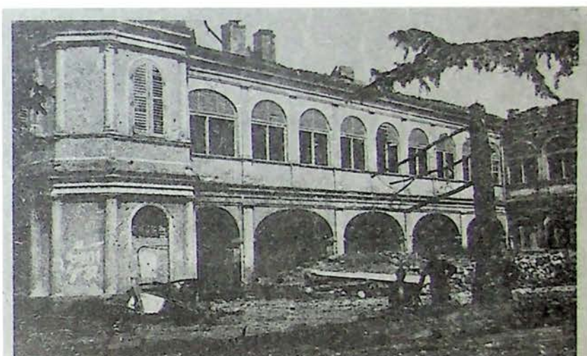
I danni subiti dal palazzo Ritter visti dal retrostante giardino (Collezione Mischou).
