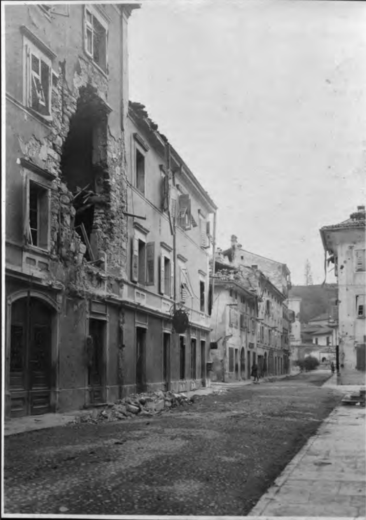
Via Seminario, zerstörte Straßenfront 188
