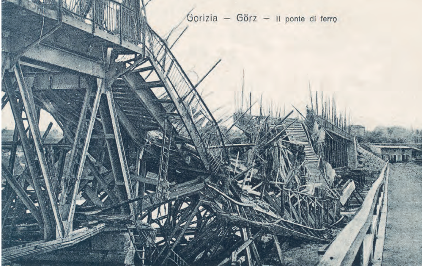
Il crollo del Ponte di ferro, anch'esso ceduto alla guerra.
