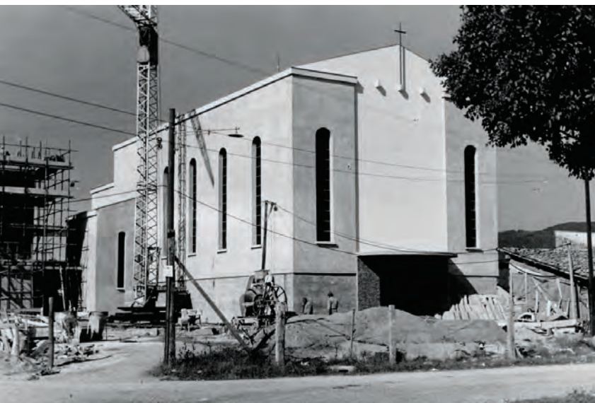
La chiesa in costruzione.
