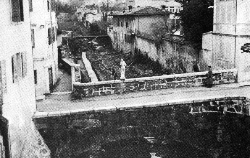
FIG. 1 Ponte di Piazzutta
