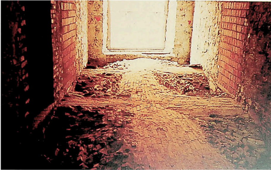
Fotografie del cantiere di Casa Lenassi, nel 1981. A sinistra, l'estradosso delle volte del piano terra, prima e dopo il consolidamento. Sotto, la cornice di gronda nuova prefabbricata e quella originale conservata, utilizzata quale modello.
