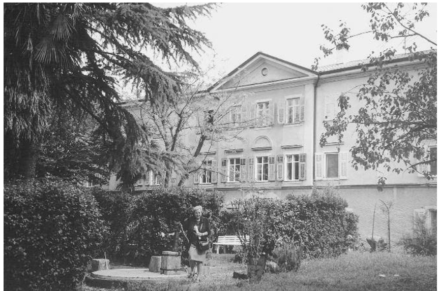
Fig. 2 - Edificio di via Parcar 2, Gorizia. (Foto Debeni, 2003)
