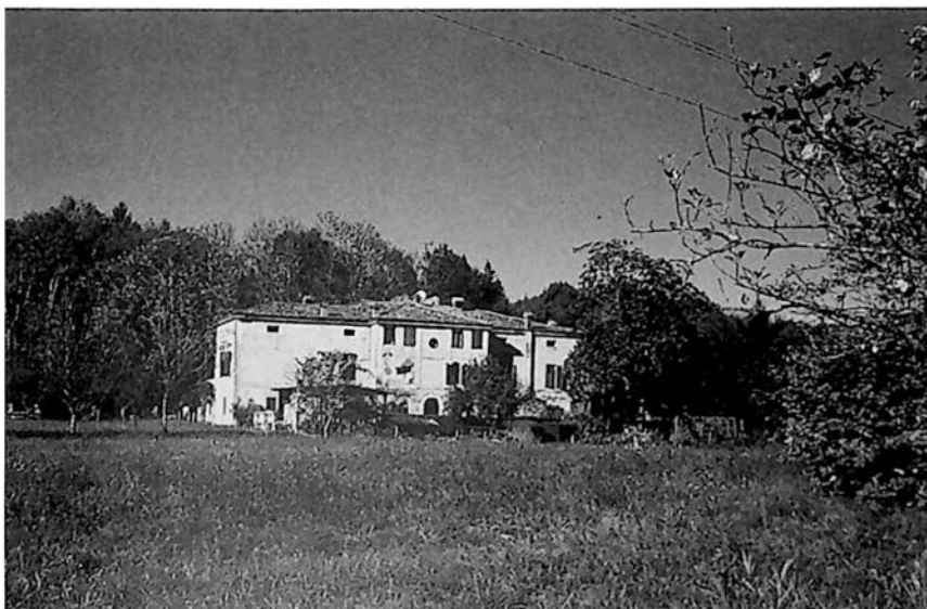
Facciata posteriore della villa.
