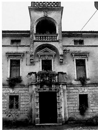
Particolare facciata anteriore.
