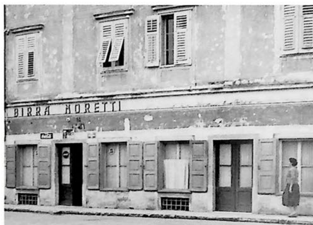
Fig. 9 - L'osteria "Alla Fortezza" negli anni '50. Notare le finestrelle della cantina usate per il travaso del vino. (Foto proprietà Giorgio Nardini)
