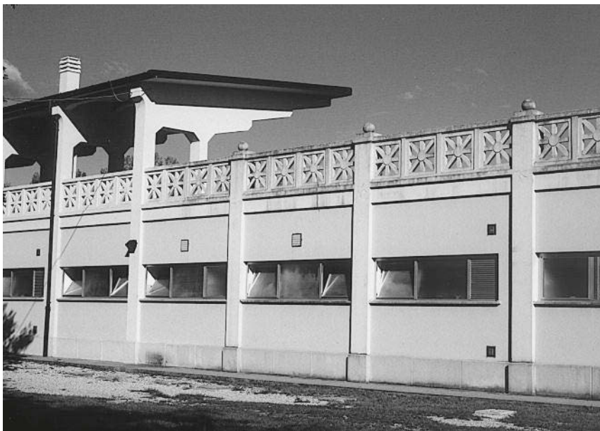
Fig. 5 - Facciata esterna della tribuna e degli spogliatoi.
