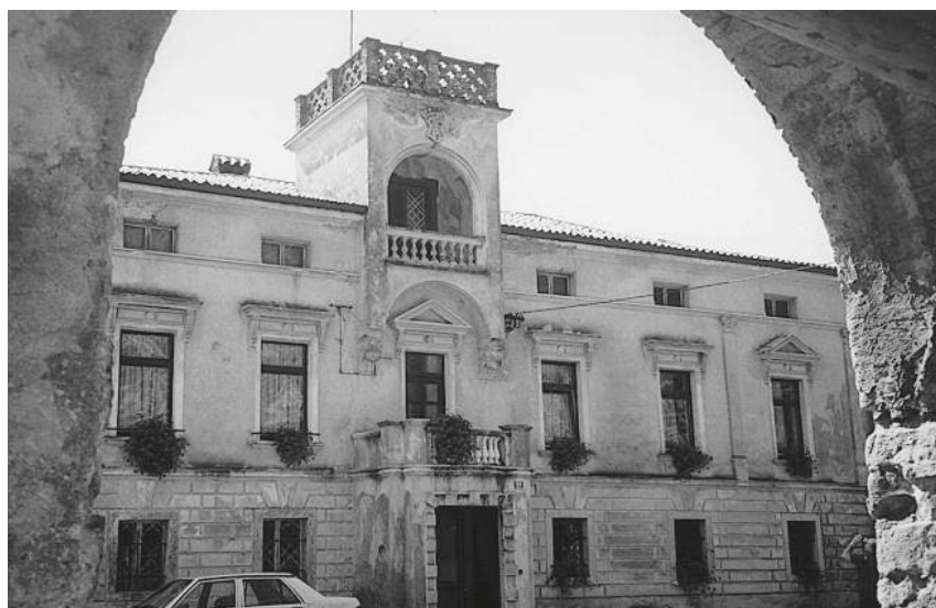
Fig. 9 - Villa de Starkenfels (foto Debeni anno 1999).
