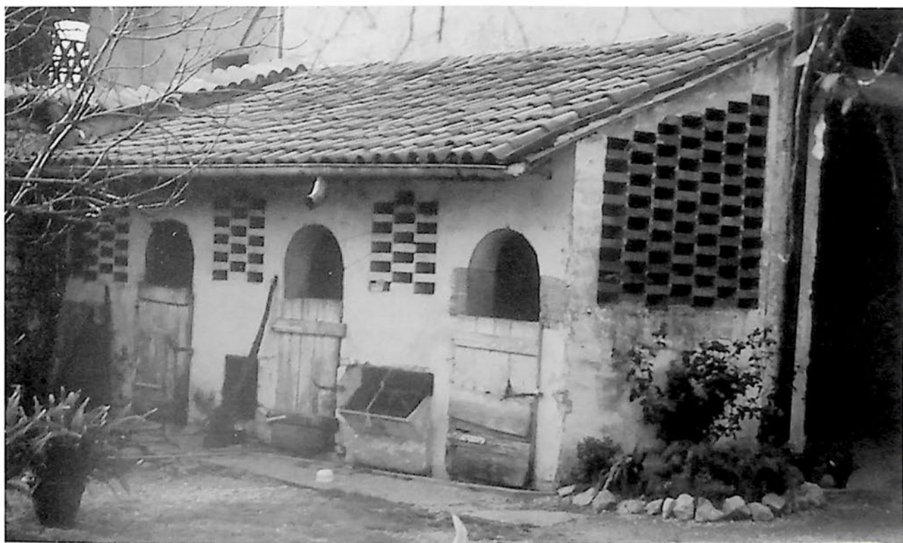
Tipico porcile (ciot, kliu) in muratura con porta bassa e trugolo aperto verso l'esterno. Fratta di Romans.
