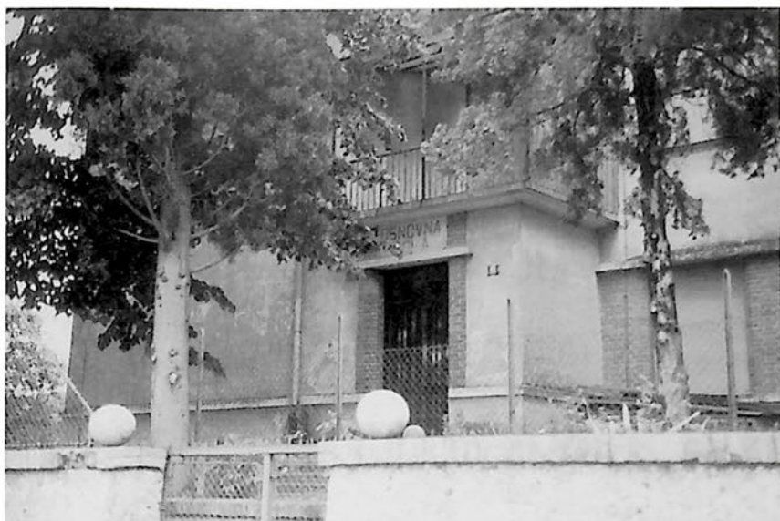
La scuola elementare di Bocavizza (Bukovica). La ripresa fotografica è di data recente. (Fototeca M. Muto).
