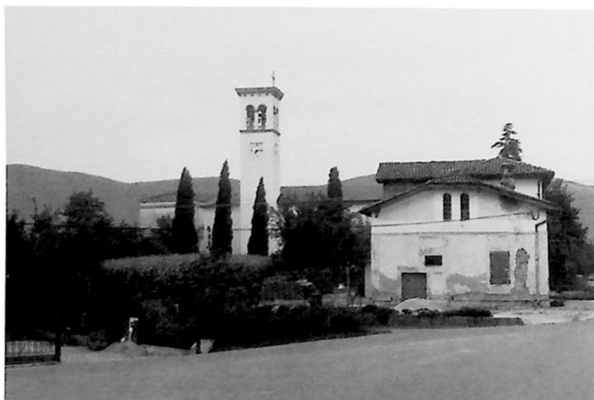
Recente immagine della chiesa di Boccavizza (Bukovica). (Fototeca M. Muto).
