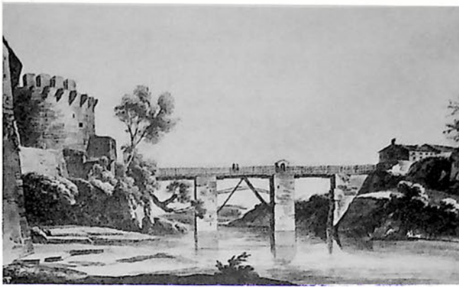
Il «Ponte del Torrione».
