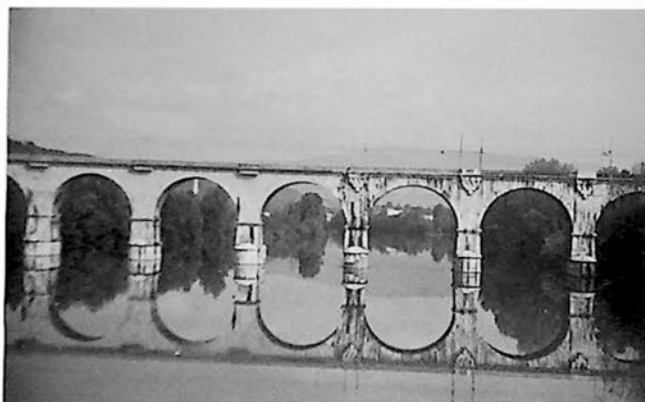
Il ponte della ferrovia (foto Anna Bombig).
