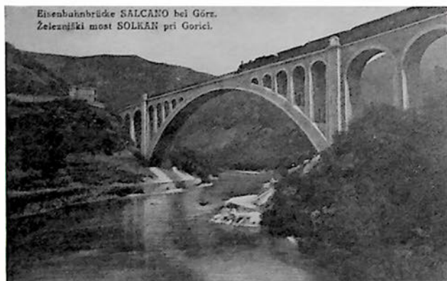
Il ponte di Salcano.
