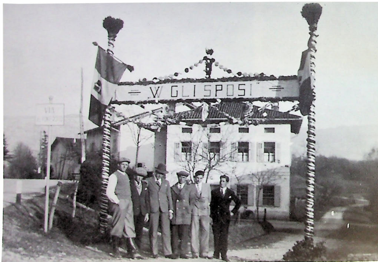
Arco nuziale in via del Ponte rotto, ai limiti di S. Rocco verso la villa Montevocchio.
