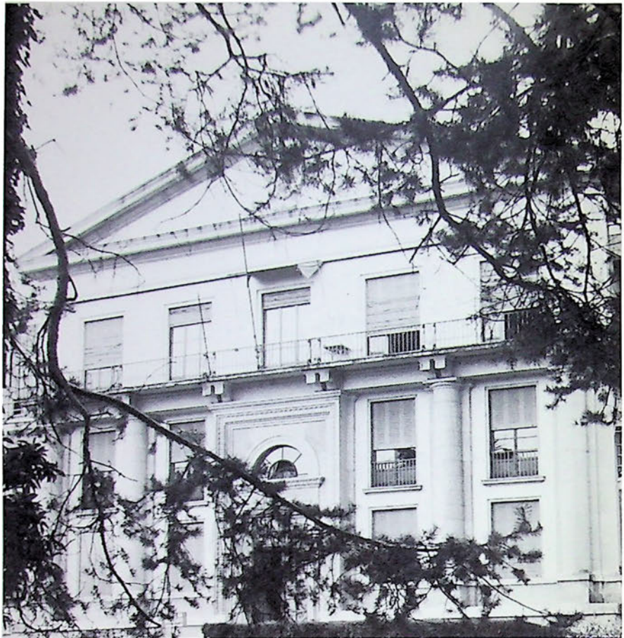
L'ex ospedale INPS che è stato costruito al posto dell'edificio della «Scuola Agraria Italiana» il cui ricordo viene tramandato dal toponimo al quale è stata intitolata la strada che lo fiancheggia.
