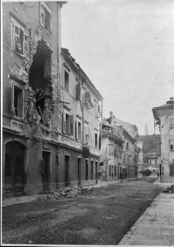
Via Seminario, zerstörte Straßenfront 188
