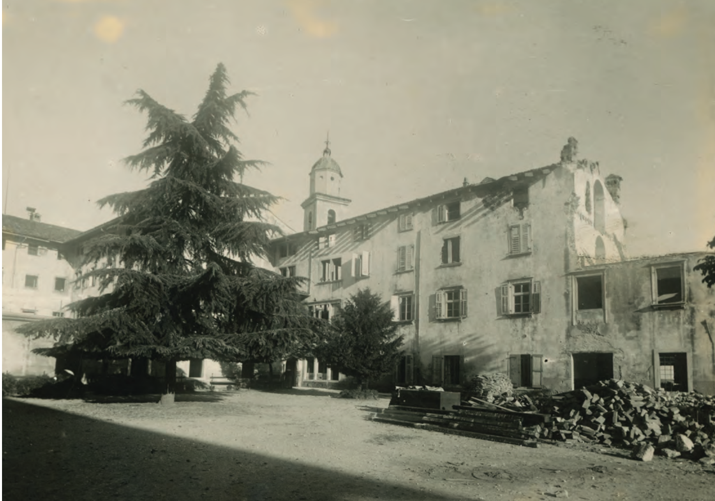
Cortile interno del monastero. In primo piano materiale per la ricostruzione.
