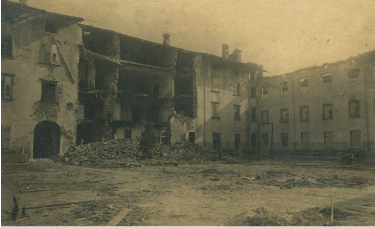
Particolare del cortile interno danneggiato dagli obici.
