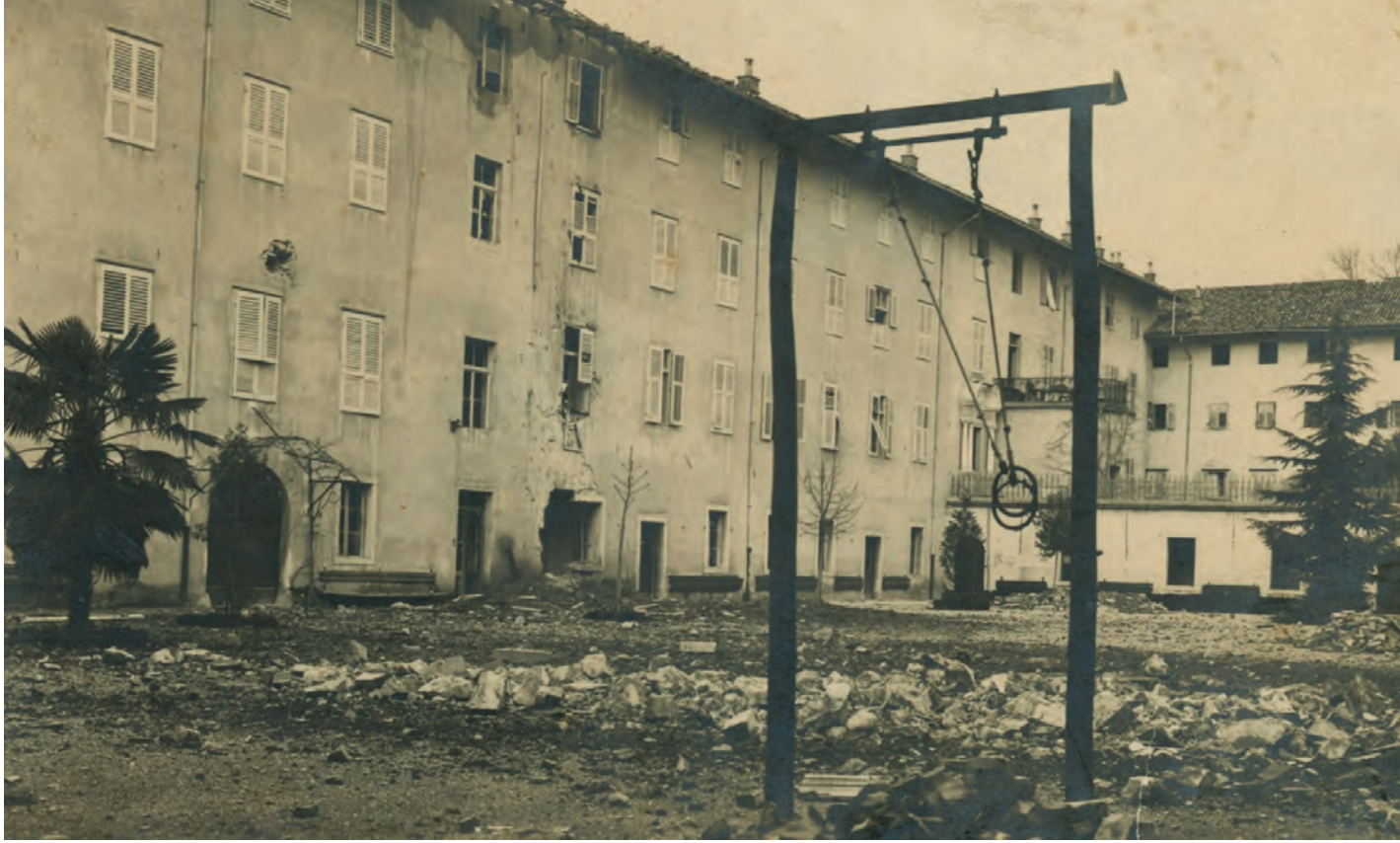
Particolare del cortile interno.
