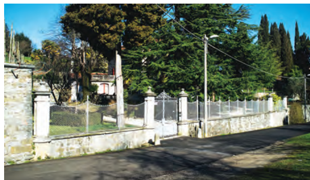
FIG. 4 La recinzione con i pilastri originali.
