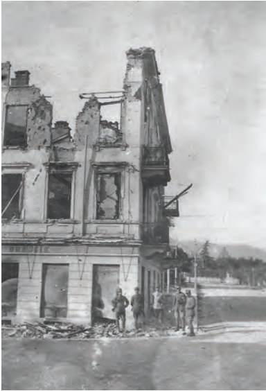
Fig. 6. La casa Drascik, o Drascek, dopo l'incendio, in una foto italiana del settembre 1916.
